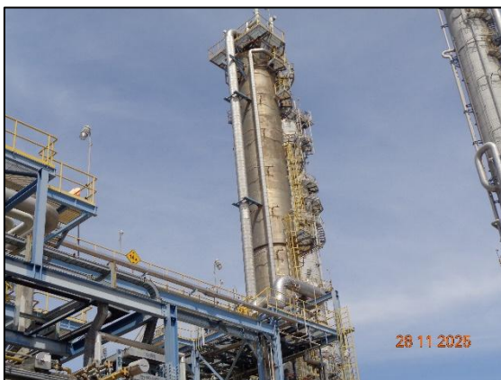
รูปที่ 3.48 ระบบพ่นน้ำล้างบนหอกลั่น
