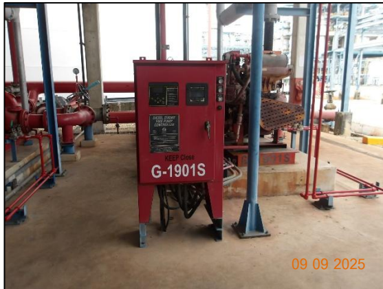
รูปที่ 3.56 เครื่องสูบน้ำดับเพลิง ชนิดเครื่องยนต์ดีเซล
