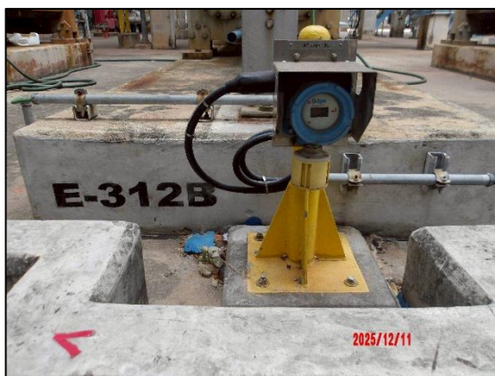
รูปที่ 3.54 Hydrocarbon Gas Detector
