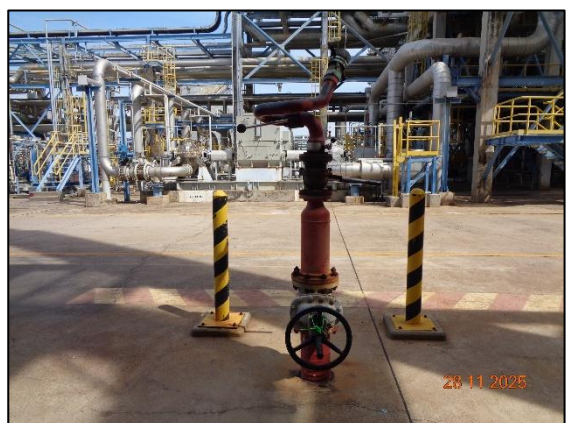
รูปที่ 3.43 Fire Water Monitor
