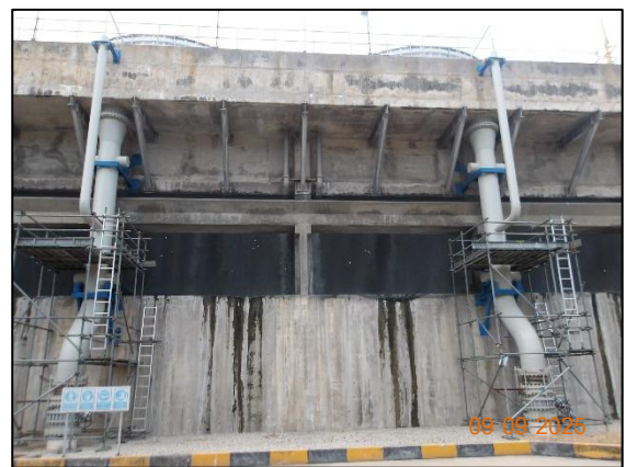
รูปที่ 3.11 Cooling Water Blowdown
