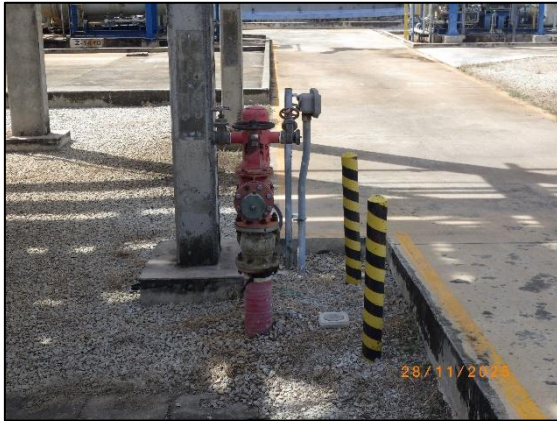
รูปที่ 3.44 Fire Water Hydrant
