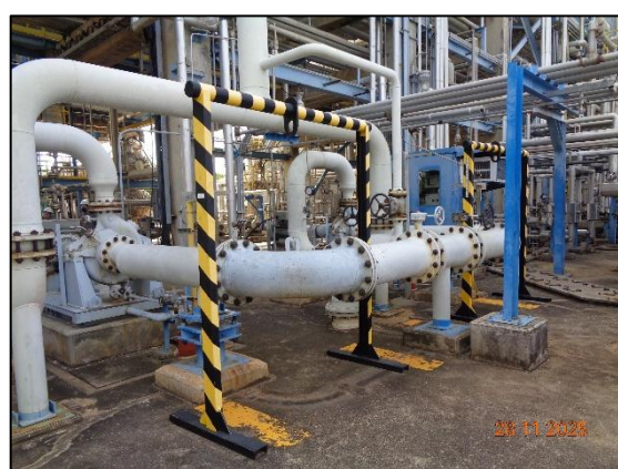
รูปที่ 3.37 Check Valve
