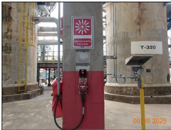
รูปที่ 3.46 Fire Alarm System
