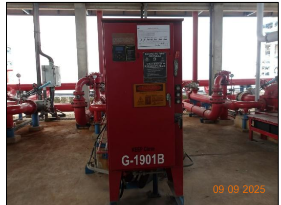
รูปที่ 3.57 เครื่องสูบน้ำดับเพลิง ชนิดไฟฟ้า
