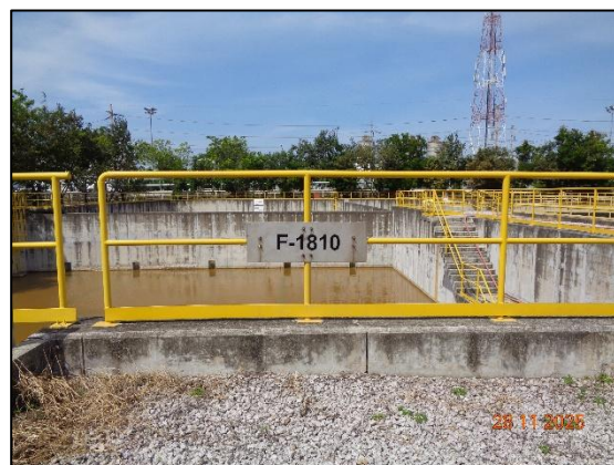
รูปที่ 3.60 บ่อ F-1810 รองรับน้ำไหลของสารเคมี
