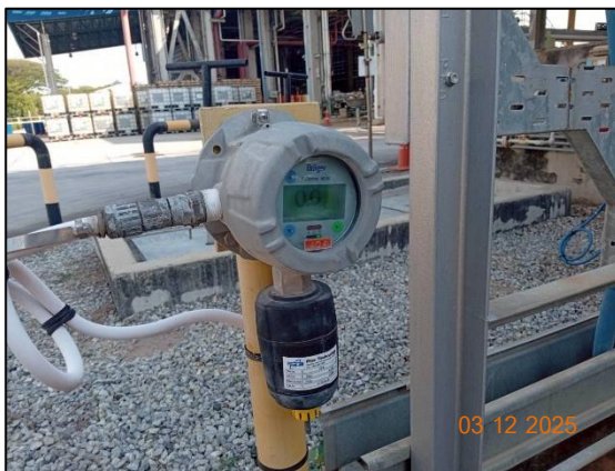
รูปที่ 3.52 Flammable Gas Detector
