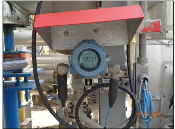
รูปที่ 3.45 เครื่องตรวจวัดอุณหภูมิ บริเวณถังเก็บเอทิลีนออกไซด์
