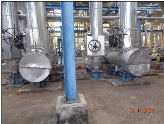
รูปที่ 3.14 Acoustic Insulation (G-624 A/B)
