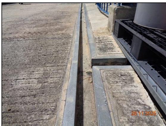
รูปที่ 3.34 ร่องระบายน้ำเพื่อป้องกันสารเคมีรั่วไหล
